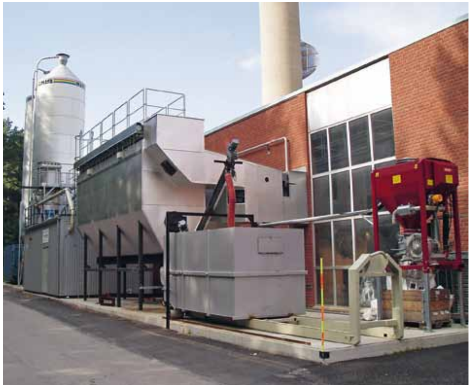
Den nya ångpannan sattes in i en befintlig lokal. Utanför finns silos för pellets, kvarnar och askhantering.
